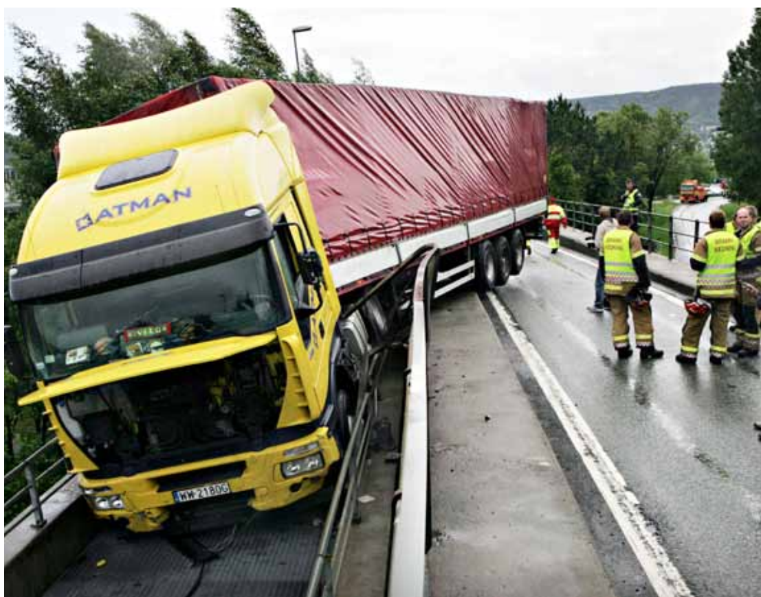
Når rekkverk ruster, kan det føre til at biler på vei ut av veier og broer ikke blir stanset, som her fra en tidligere situasjon ved E18 i Drammen, der en lastebil var nær ved å tippe utfor en bro. FOTO: HAUGE JON
